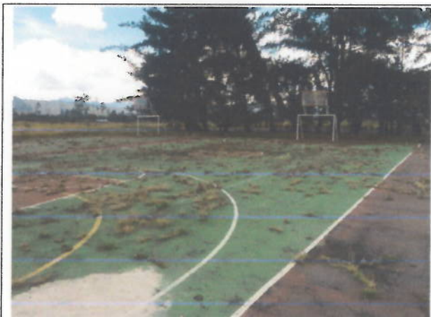
VISTA ÁREA DEPORTIVA (CANCHAS MÚLTIPLES)
