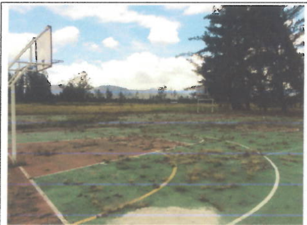
VISTA ÁREA DEPORTIVA (CANCHAS MÚLTIPLES)
