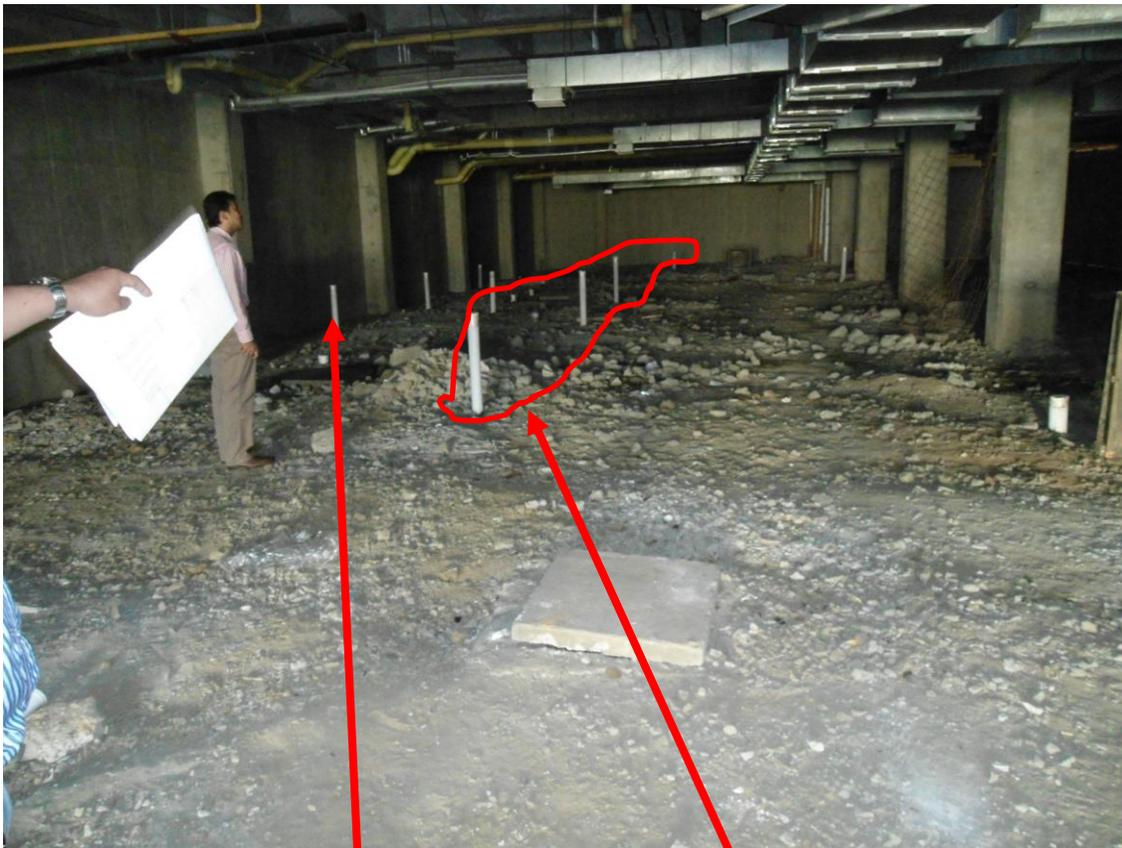
Corte y adecuación de tubería de acero al carbón Schedule 40
