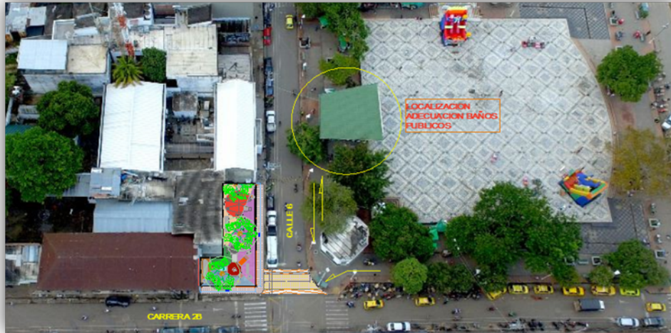
IMAGEN 1. Fotografía en planta con ubicación de las áreas a intervenir – Imagen suministrada por el consultor
