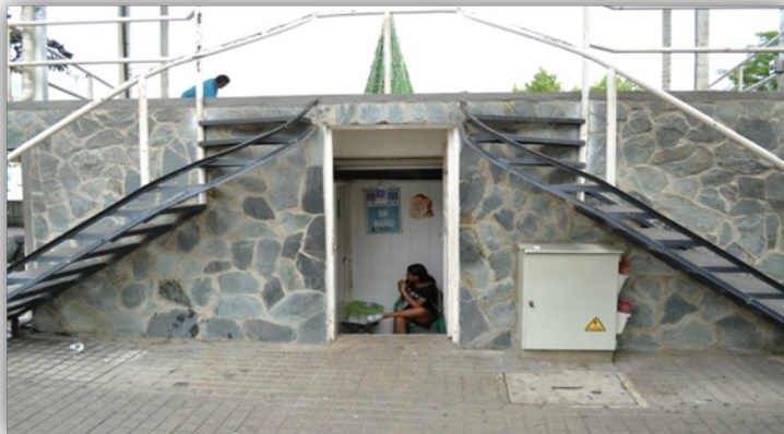
IMAGEN 3. Fotografía del acceso a los baños - Imagen suministrada por el consultor
