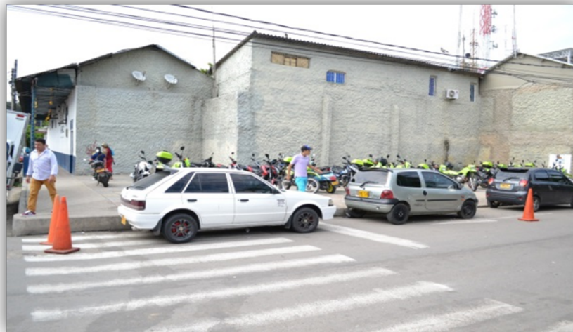
IMAGEN 2. Fotografía panorámica con estado de los sardineles y construcciones colindantes – Imagen suministrada por el consultor
