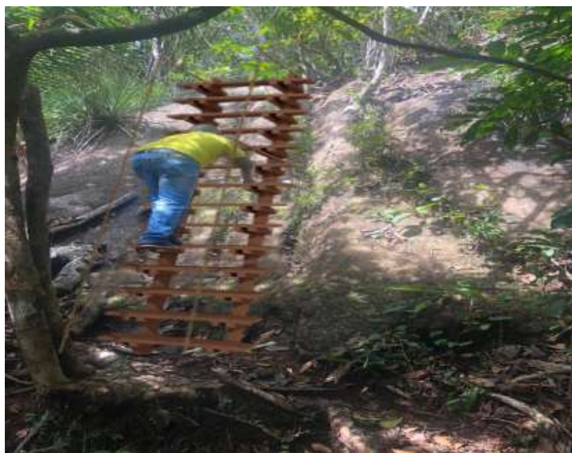
Construcciones de escaleras tipo gato con anclajes en roca
