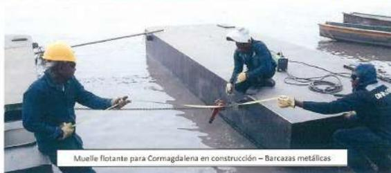
Muelle flotante para Cormagdalena en construcción – Barcazas metálicas
