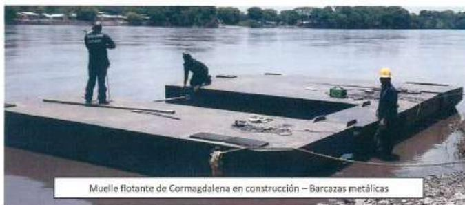
Muelle flotante de Cormagdalena en construcción – Barcazas metálicas
