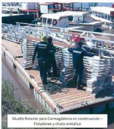
Muelle flotante para Cormagdalena en construcción – Flotadores y chasis metálico
