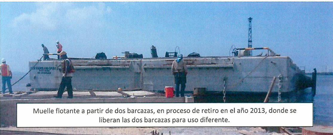
Muelle flotante a partir de dos barcazas, en proceso de retiro en el año 2013, donde se liberan las dos barcazas para uso diferente.
