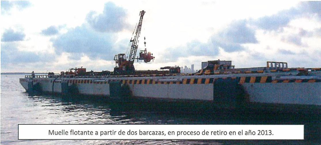
Muelle flotante a partir de dos barcazas, en proceso de retiro en el año 2013.
